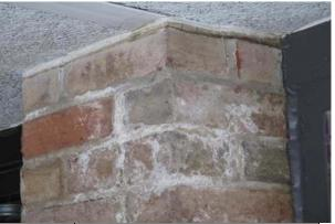
**EXTERIOR WALL WITH** #26: EFFLORESCENCE
