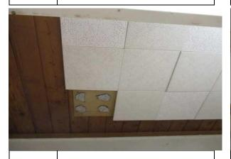
CEILING TILE POSSIBLY #5: **CONTAINING ASBESTOS**
